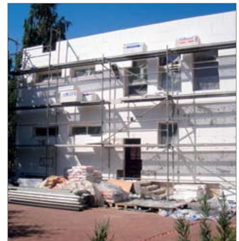
A PRZEDSZKOLE NR 1 W TRAKCIE TERMOMODERNIZACJI
