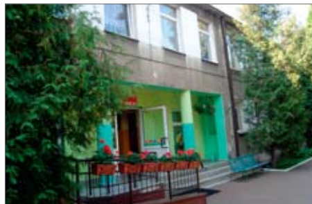
A PRZEDSZKOLE NR 1 PRZED REMONTEM
