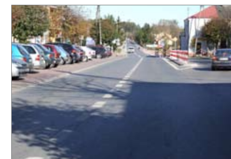
▲ PRZEBUDOWANA DROGA POWIATOWA W NASIELSKU
