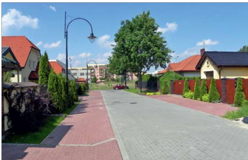
UL. BERLINGA ZYSKA TEŻ DODATKOWE OŚWIETLENIE ZARÓWNO JEZDNI, JAK I CIĄGÓW PIESZYCH.
