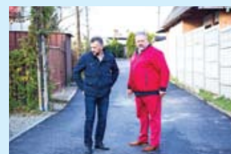
REMONTY DRÓG I CHODNIKÓW
