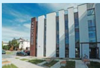
CD. MODERNIZACJI BIBLIOTEKI
